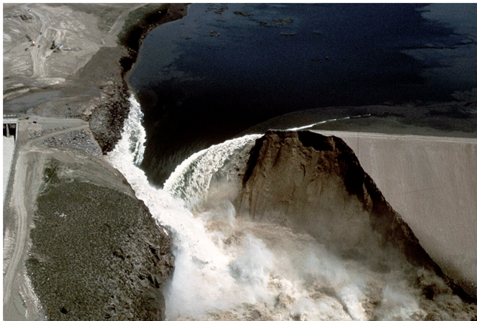
Fig. 4 Falla de la presa Teton, en el río Teton, al este de Idaho, el 5 de junio de 1976. Posiblemente se trate de un caso raro de una onda mixta cinemático-dinámica.
