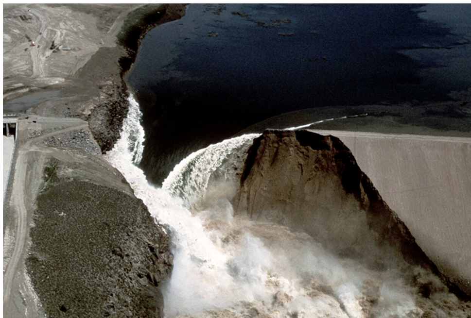
Fig. 1 Falla de la presa Teton, en el río Teton, al este de Idaho, el 5 de junio de 1976; posiblemente un caso raro de la ocurrencia de una onda cinemático-dinámica mixta.
