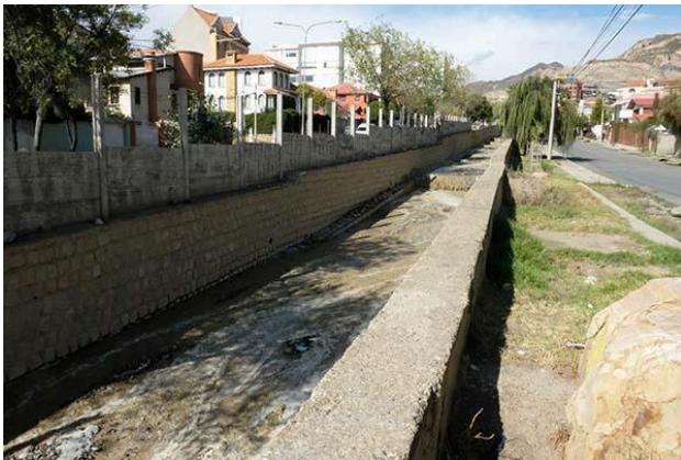
Figura 1. El río canalizado Huayñajahuira river, en La Paz, Bolivia.
